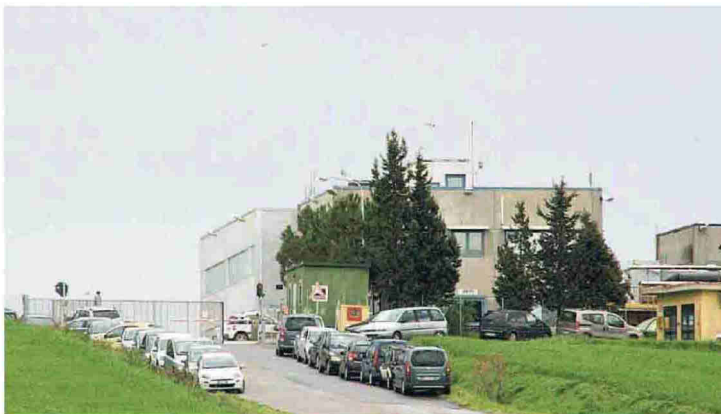
Una veduta dell'ingresso di Scapigliato
