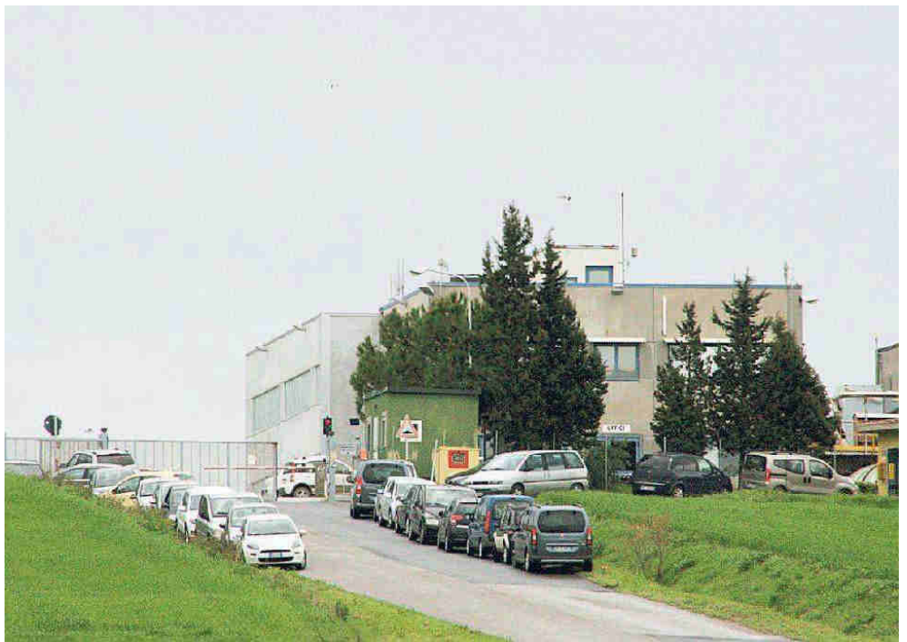
L'ingresso della discarica di Scapigliato
