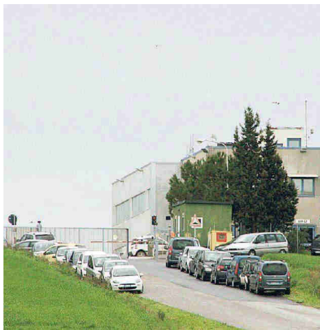
L'ingresso del polo impiantistico di Scapigliato
