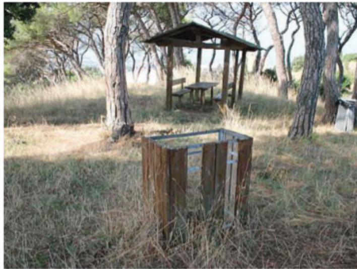
Strutture in legno nel parco dei Poggetti
