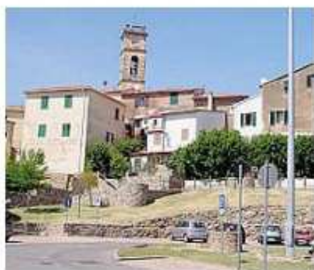
Una veduta di Castelnuovo
