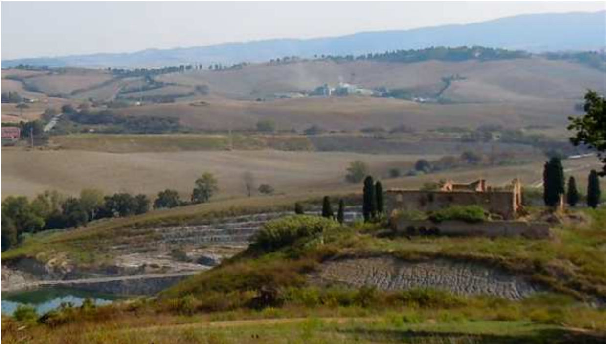
Fabbricato in rovina di casa Staggiano circondato dalla cava. Settembre 2013.
